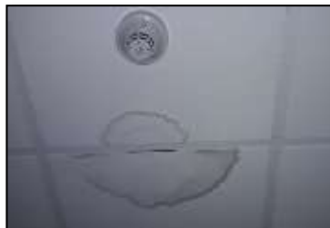
IMAGEN # 1 PINTURA DE PARED Y CENEFA DETERIORADAS POR LA FILTRACIÓN DE AGUA 2º PISO, SALA DE ESTAR
